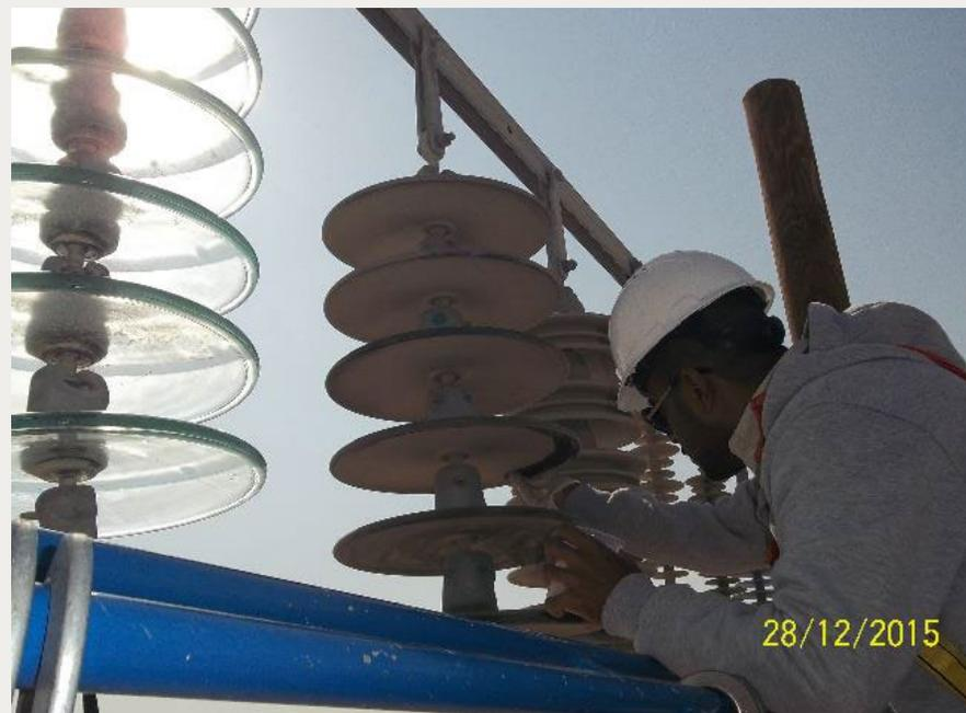
Рис.17 Неравномерное распределение загрязнения, отбор образцов
