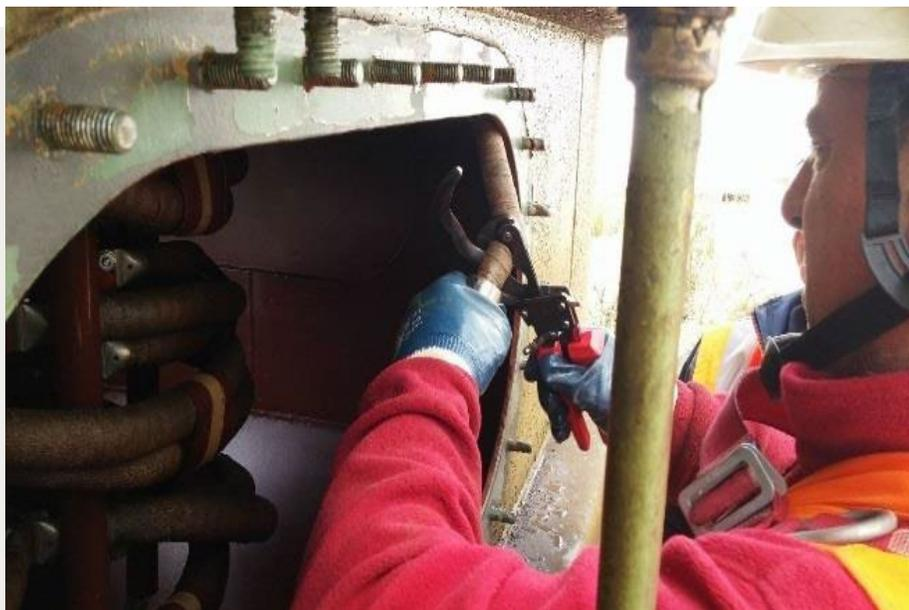
Рис.16 сбор образцов бумаги из проводов
