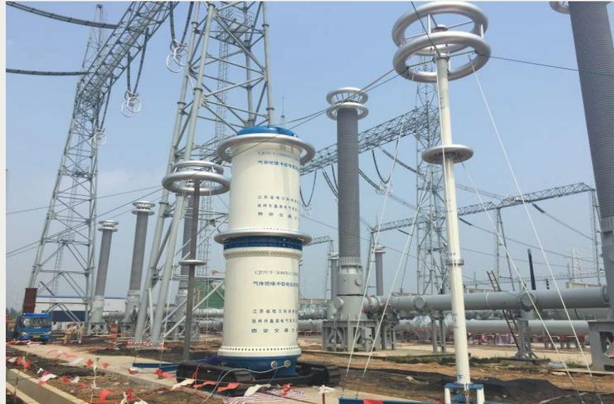
Рис.18 б) Импульсный генератор с элегазовой изоляцией
