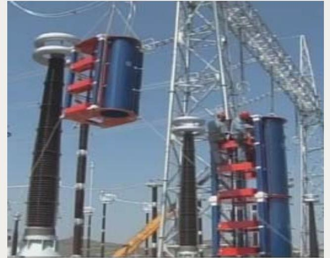
Рис.18 в) Монтаж модульного генератора в поле
